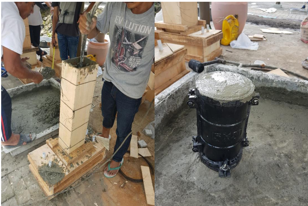
PROSES PENGECORAN BALOK DAN SILINDER
