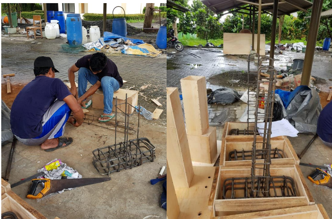
PROSES PENULANGAN BALOK
