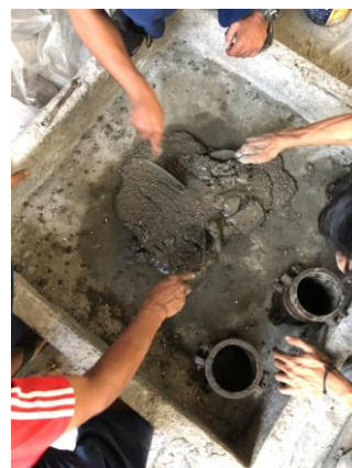
Penuangan Beton Ke Dalam Cetakan
