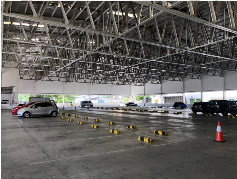
Area Parkir Mobil Belakang Gedung
