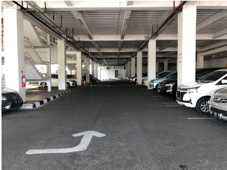
Area Parkir Mobil Belakang Gedung
