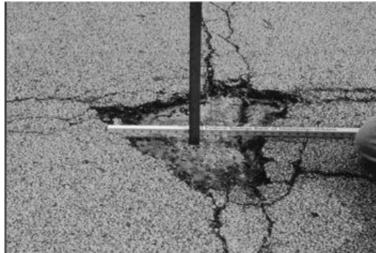
Gambar 2.17. Kerusakan Lubang
