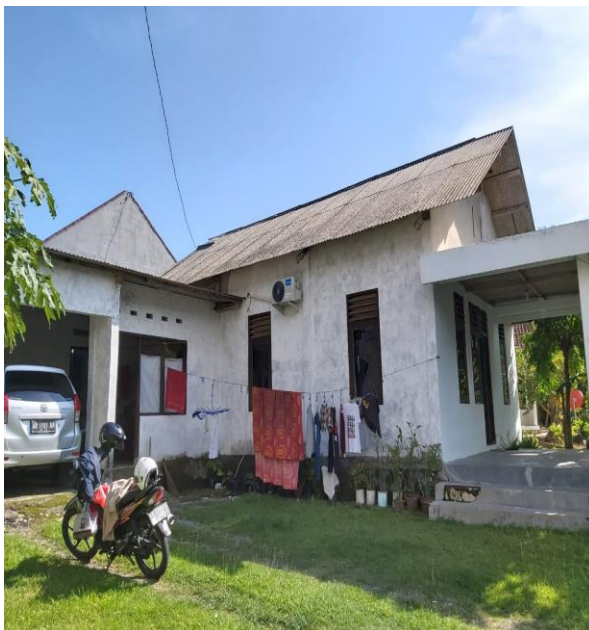
Gambar 1.3. Tampak Samping Bangunan GPdI Immanuel Sedayu
