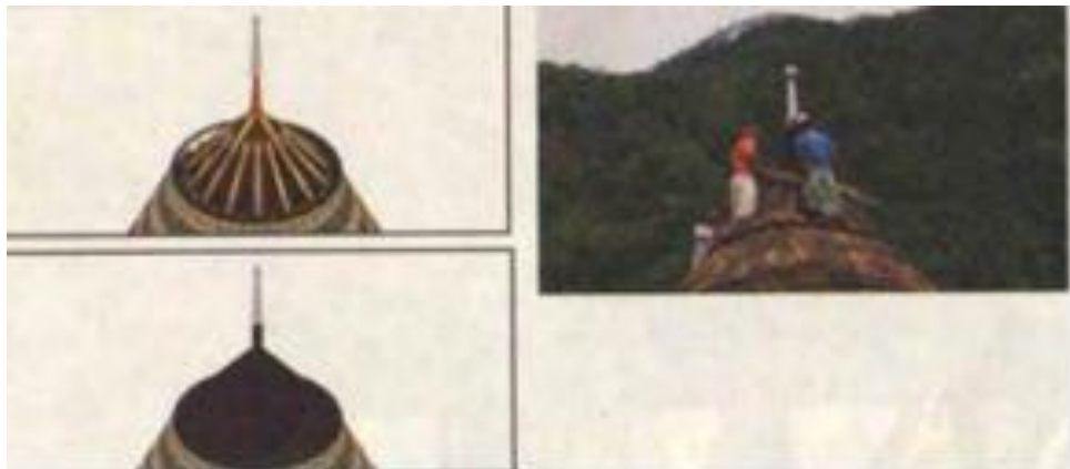
Gambar 3.41 Pemasangan wolet ngando
