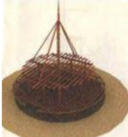
Gambar 3.31 Pemasangan pengga ngando
