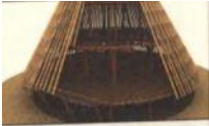
Gambar 3.39 Pemasangan papan lantai untuk tenda dan lobo
