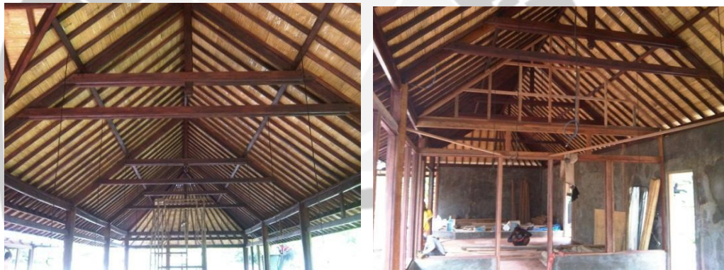
Gambar 4. 1 Struktur Atap Restoran Jepang Ryoshi Ubud Sumber: Penerapan Elemen-Elemen Interior Gaya Jepang Pada Restoran Ryoshi Ubud
