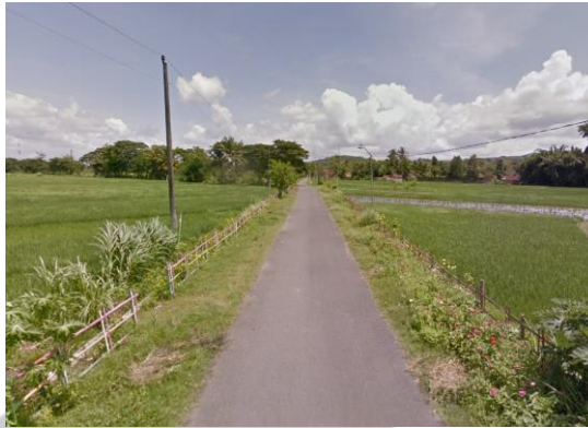
Gambar 4. 31 Kondisi Jalan Desa, Dusun Puton (Sumber: Dokumentasi pribadi, 2019)
