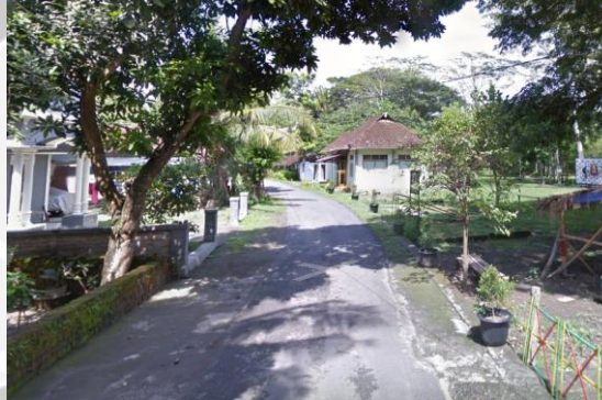
Gambar 4. 32 Kondisi Jalan Kawasan Watu Ngelak (Sumber: Dokumentasi pribadi, 2019)
