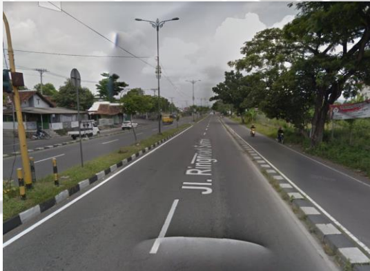
Gambar 4. 29 Kondisi Jalan Jogja-Bantul (Sumber: Google Maps, 2019)
