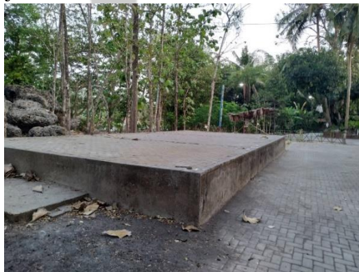
Gambar 4. 24 Kondisi Panggung Pertunjukan Outdoor di Watu Ngelak (Sumber: Dokumentasi Pribadi, 2019)
