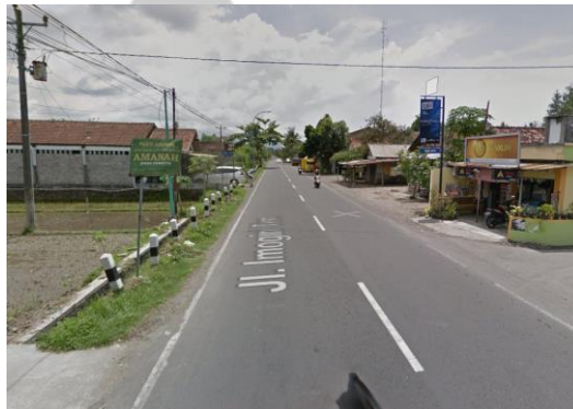
Gambar 4. 30 Kondisi Jalan Imogiri Timur (Sumber: Dokumentasi pribadi, 2019)
