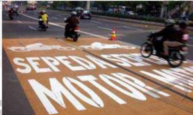
Gambar 2.2 Lajur Sepeda Motor Inklusif di Tangerang Lajur sepeda motor inklusif disarankan digunakan pada ruas jalan yang memiliki banyak kebutuhan akses ketata guna lahan di sisi jalan, sehingga kendaraan lainya dapat diberikan akses untuk memotong lajur sepeda motor ke arah tata guna lahan.
