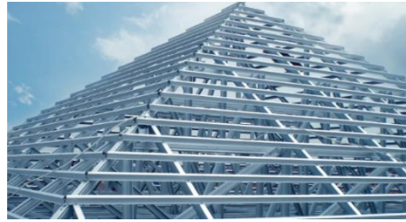
Gambar 6. 9 Struktur Atap Rangka Baja
