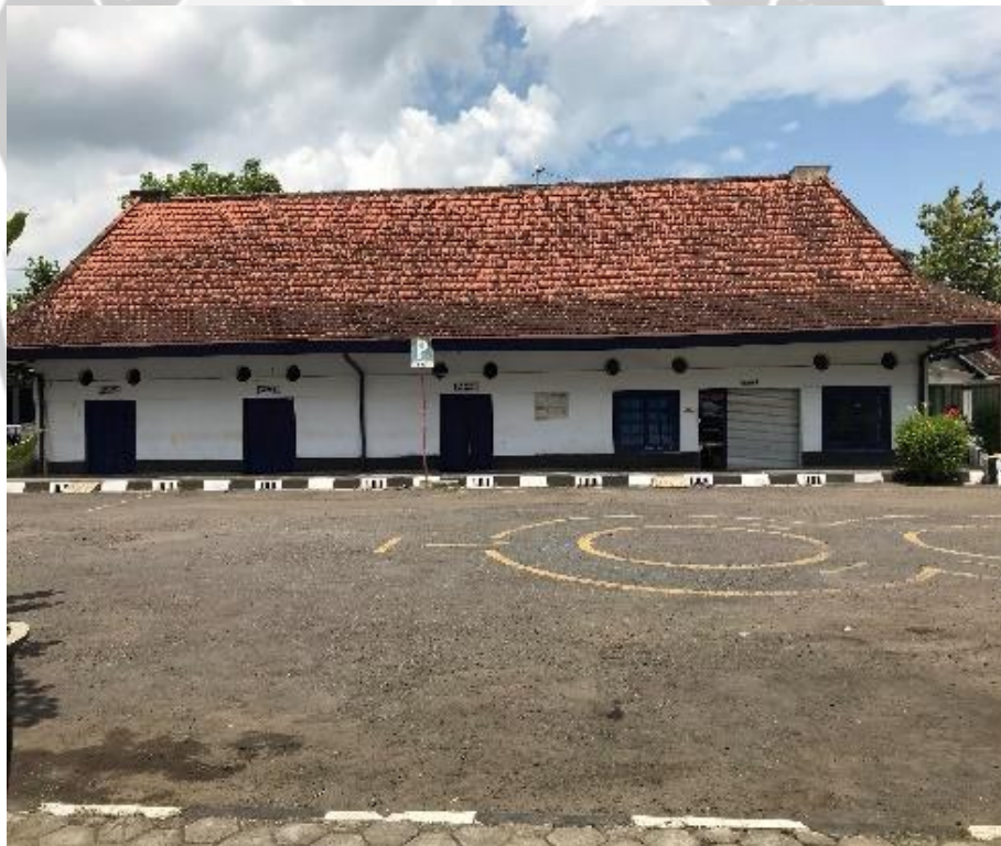
Gambar 2. 1 Bangunan Induk Terminal (Sumber : Dokumentasi Penulis 2019)
