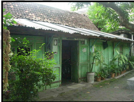
Gambar 6.3 Rumah penduduk asli ledok macanan Sumber : dokumentasi penulis,2009
