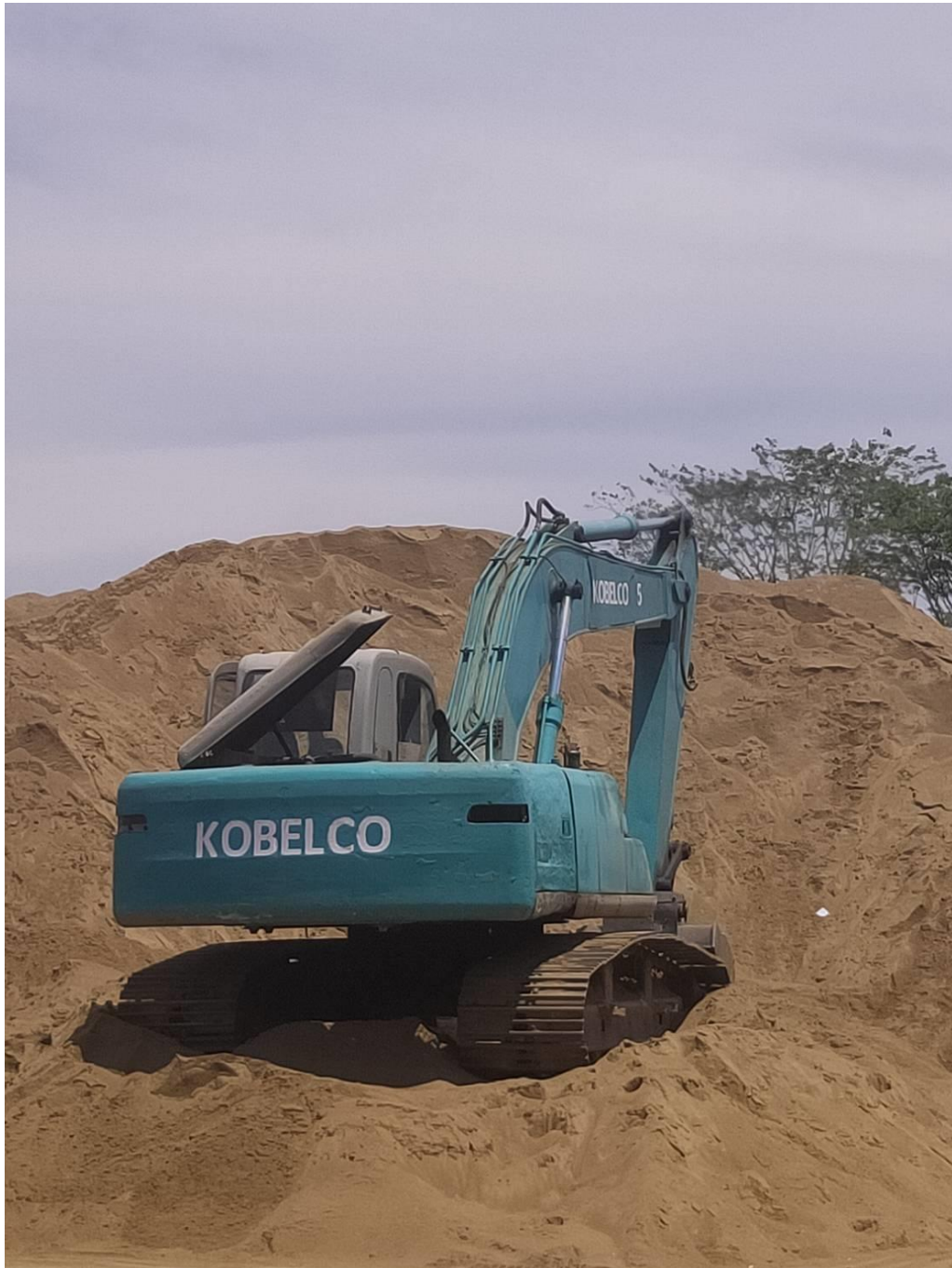
Lampiran 3: Excavator yang digunakan CV. Sumber Pasir Utama untuk mengelola persediaan dan penambangan
