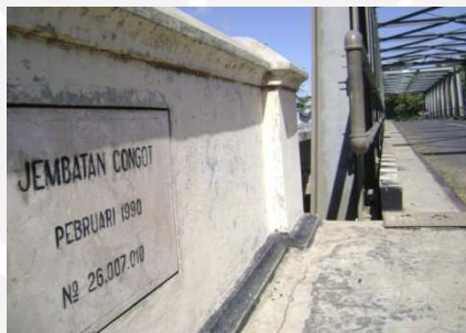
Gambar 1.5. Prasasti Pembangunan Jembatan Congot
