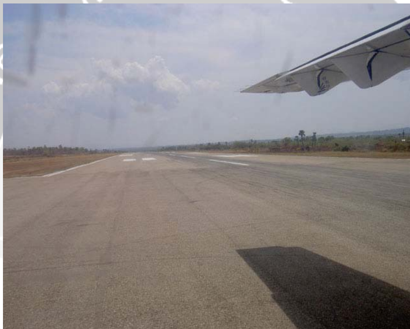
Gambar 2.3.Landas pacu ( runway ) Bandar Udara Haji Hasan Aroeboesman Ende
