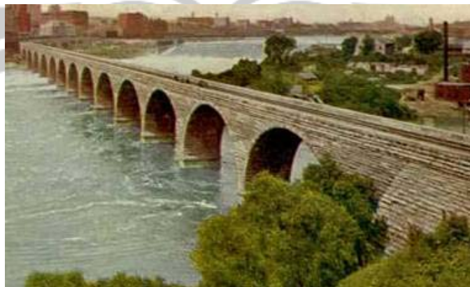
Gambar 2.40. Jembatan Pelengkung Dari Batu ( Stone Arch Bbridge ) Di Minneapolis
