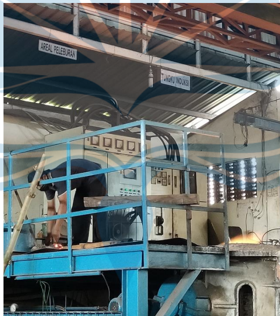
Foto Areal Peleburan Besi Skrap dan Tungku Induksi
