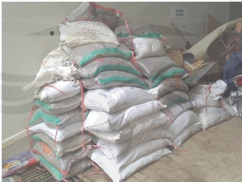
Beban Pre-loading Seberat 1,85 Ton
