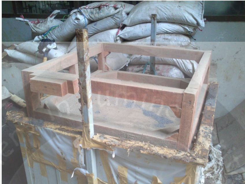
Pemasangan Bak Untuk Beban Pre-loading
