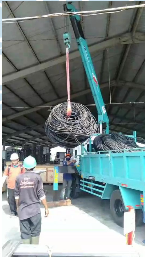
Pemindahan Material Menggunakan Crane
