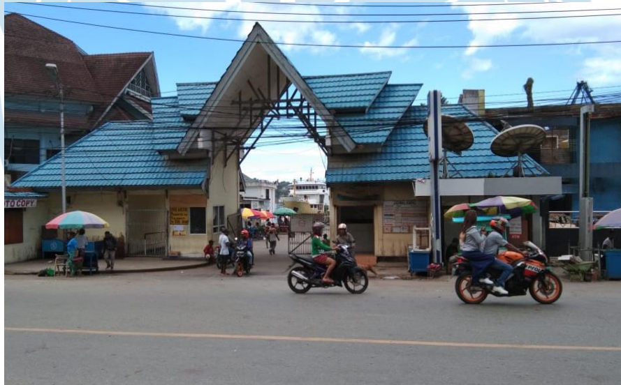
Gambar 3.10 Pintu Masuk dan Pintu Keluar Pelabuhan (Bagian Luar) (Ketika Kapal Belum Masuk Pelabuhan)
