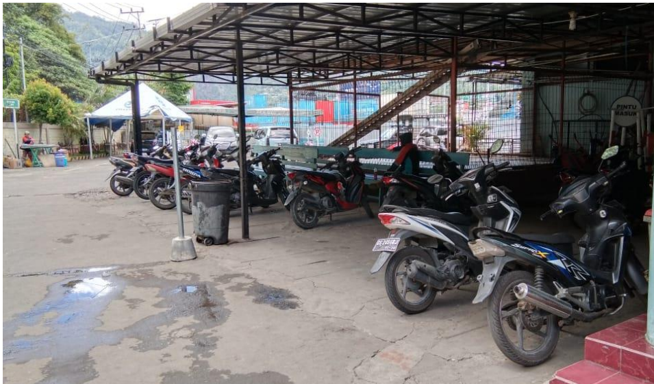
Gambar 3.3 Area Parkir Kendaraan Milik Karyawan pada Sisi Bagian Barat Terminal Penumpang
