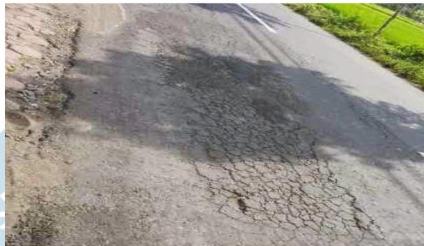
**Gambar 2.9** Kerusakan Jalan Retak Diagonal
