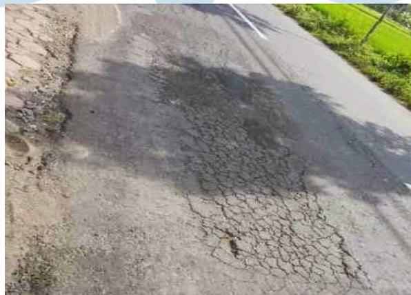
**Gambar 2.12** Kerusakan Jalan Retak Blok
