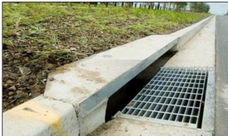
Gambar 3. 9. Drainase Buatan Saluran Air
