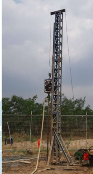
Gambar 3.7 Bored Pile Mini Crane
