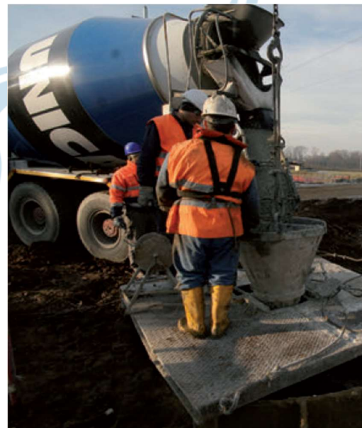
Gambar 3.21 Pengecoran dengan Ready Mix Concrete
