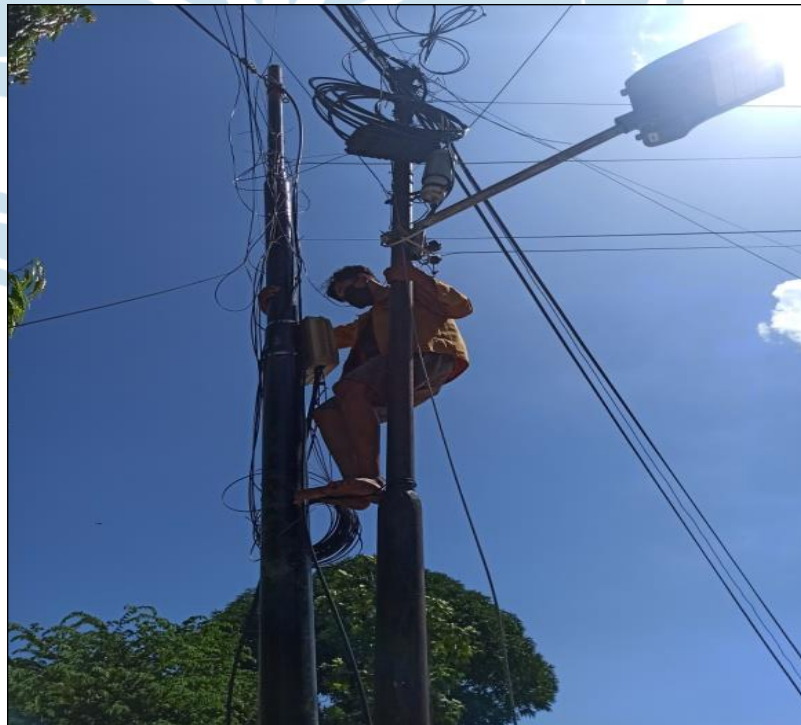
Gambar 4. Karyawan Teknisi memperbaiki Kerusakan pada Tiang Jaringan
