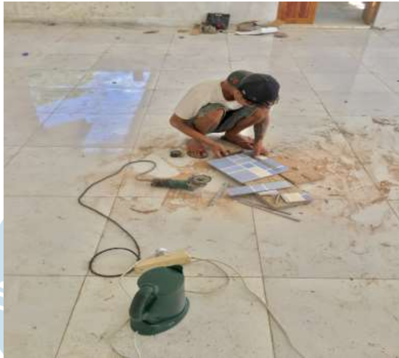
Pekerja Tidak Menggunakan APD saat memotong Keramik
