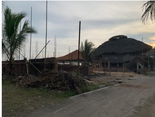
Gambar 5.2.3 Kondisi eksisting bangunan luar
