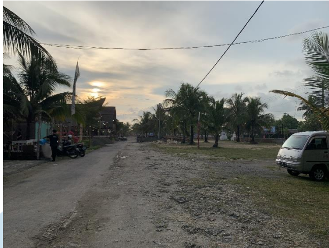
Gambar 5.2.2-3 Kondisi Eksisting Pedestrian
