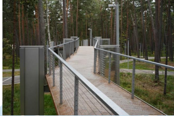
Gambar 7. Jembatan Pejalan Kaki
