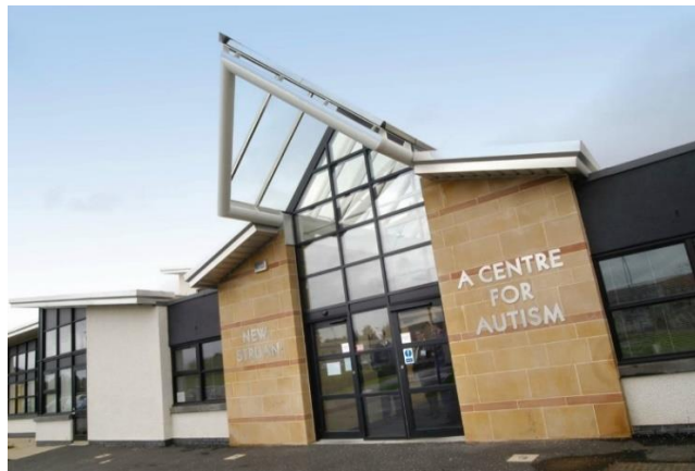
Gambar 2. 3 Tampak depan New Struan School di Skotlandia
