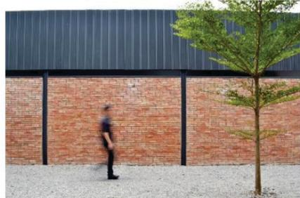
Gambar 2.3 Pemilihan material bata merah khas singkawang dengan model konstruksi baja.
