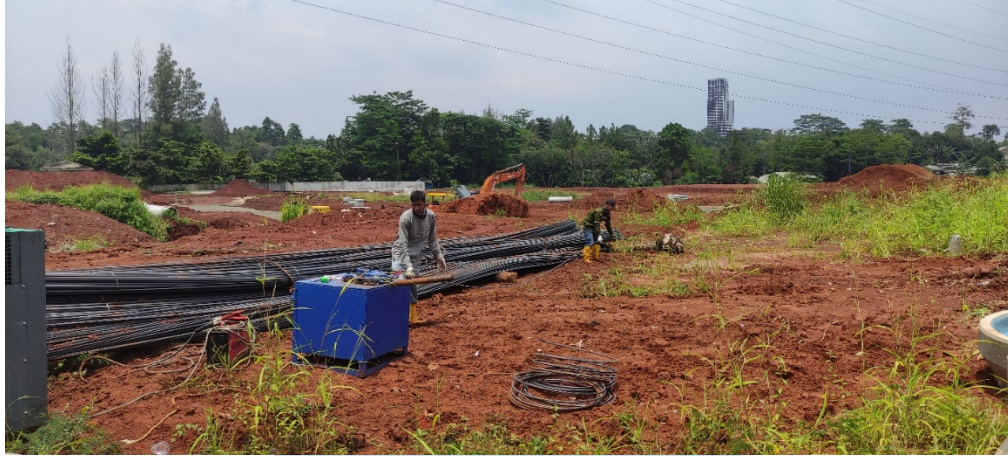
Pembuatan roll besi keranjang menggunakan bar bending
