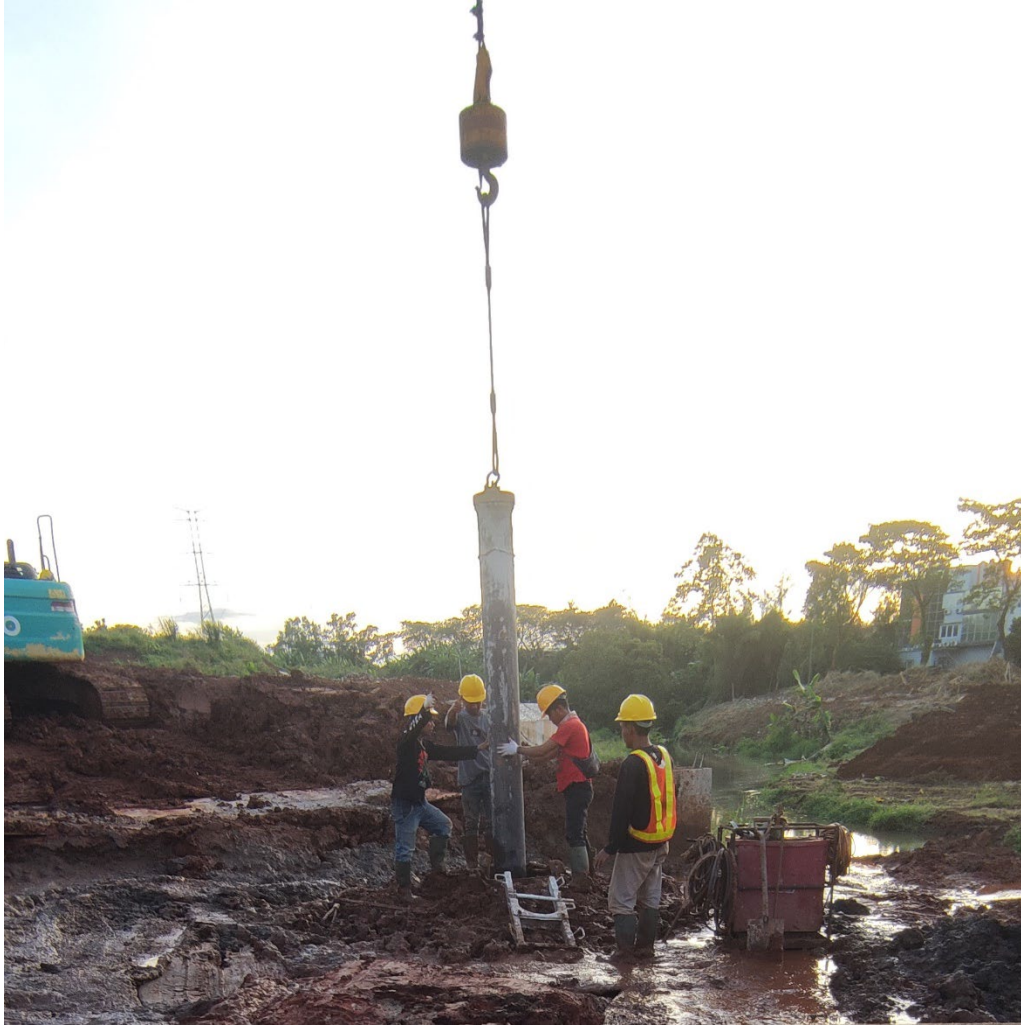
Pemasangan pipa tremie kedalam lubang
