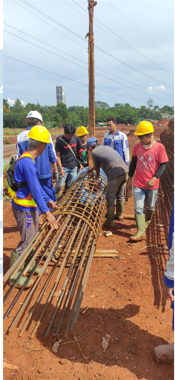
Pemasangan cell pada besi keranjang
