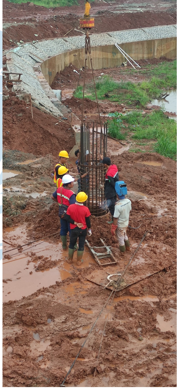
Pemasangan beton decking
