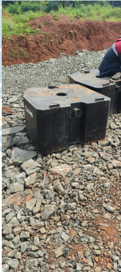
Counter weight dengan berat 2 ton untuk crane
