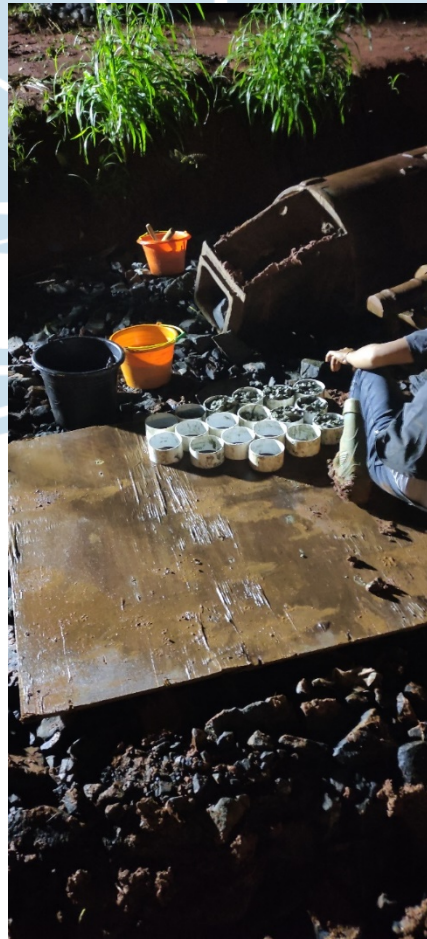
Proses pembuatan beton decking
