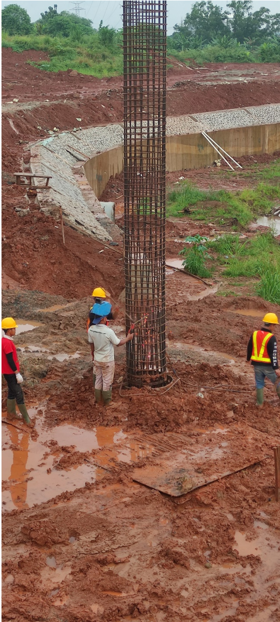
Pemasangan besi keranjang
