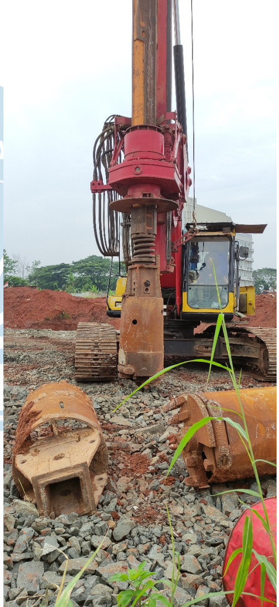
Pemasangan mata bor
