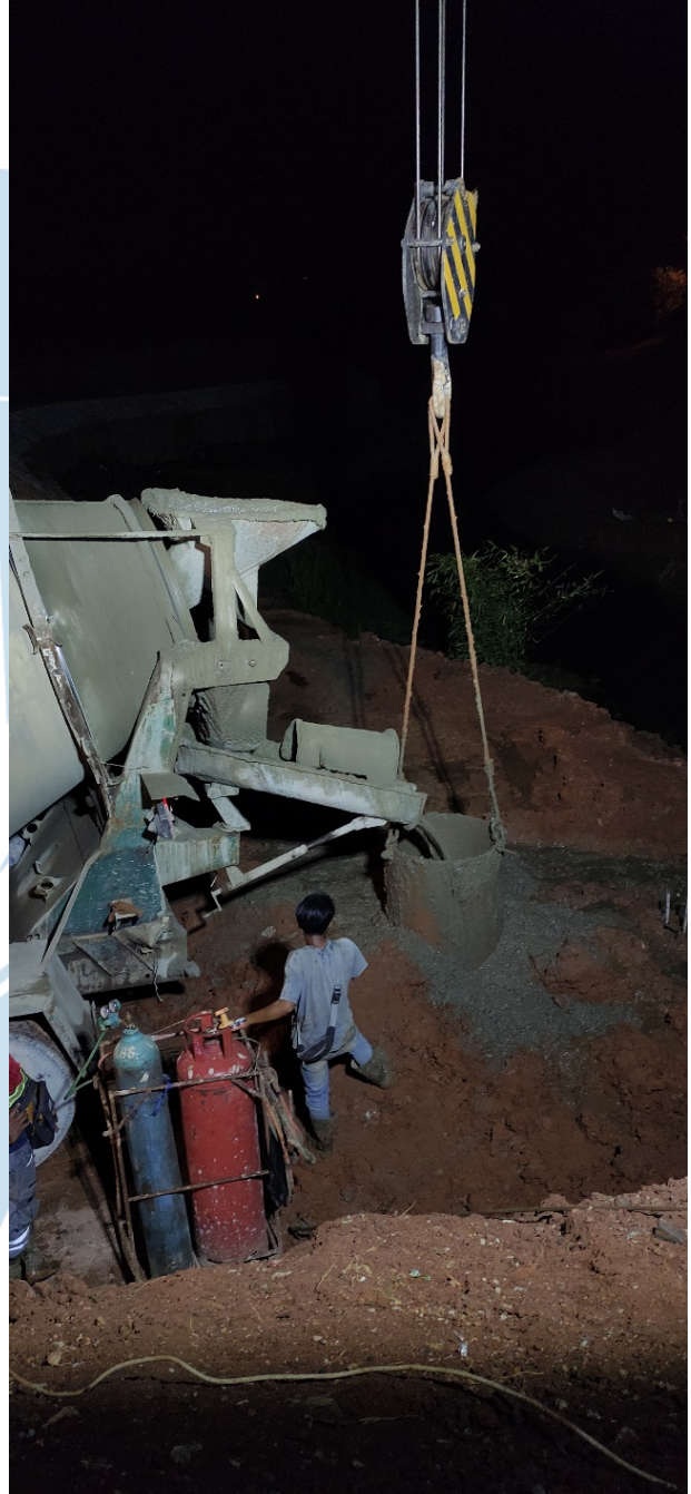
Proses pengecoran hingga rata tanah
