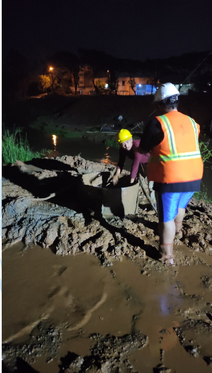
Pengecekan kabel hidrolik setelah pengecoran
