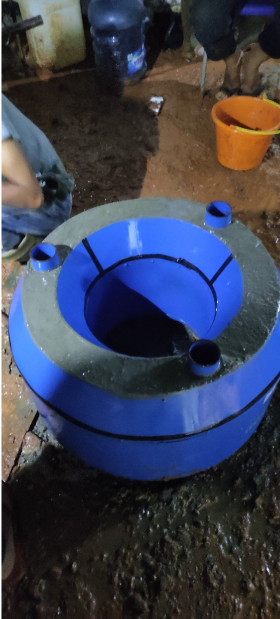
Benda cell untuk pengujian test pile
