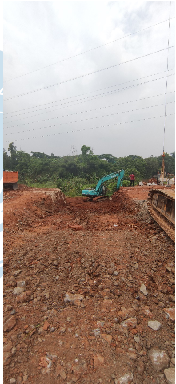
Excavator membuat ramp
