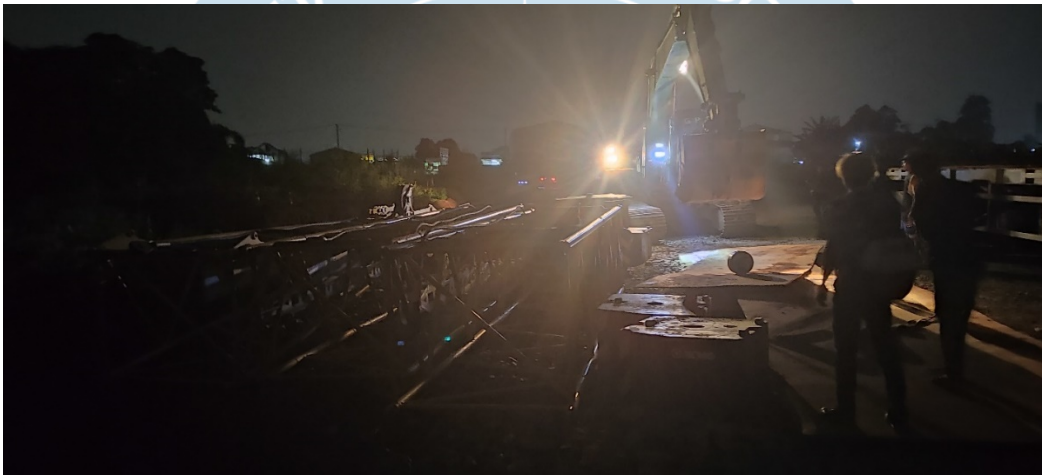
Mobilisasi peralatan kerja dan boom crane service
