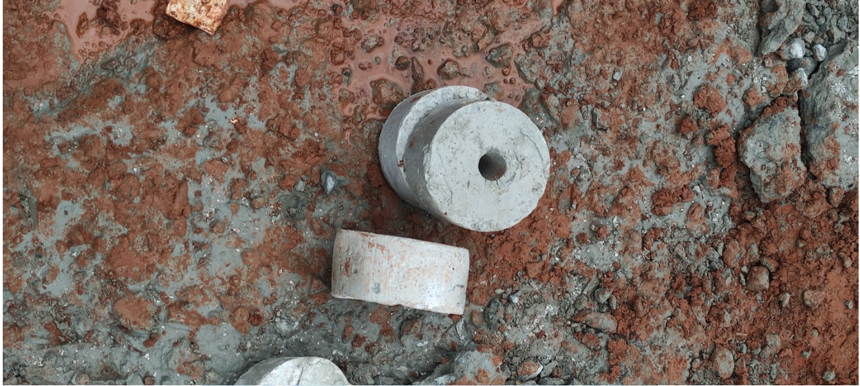
Beton decking untuk selimut beton
