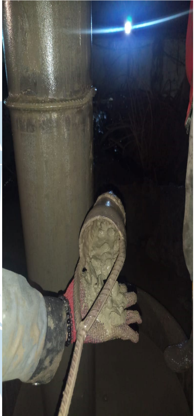
Pengecekan beton pada lubang dengan torpedo
