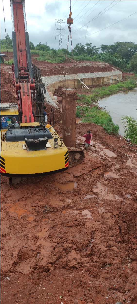
Proses pemasangan casing
