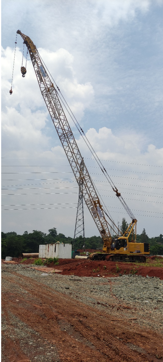
Mesin crane yang sudah setting
