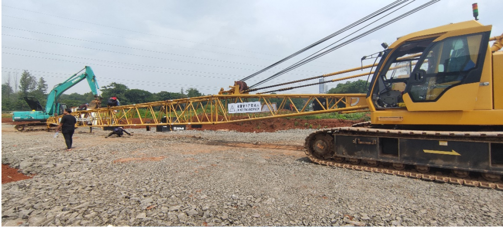
Proses pemasangan boom crane
