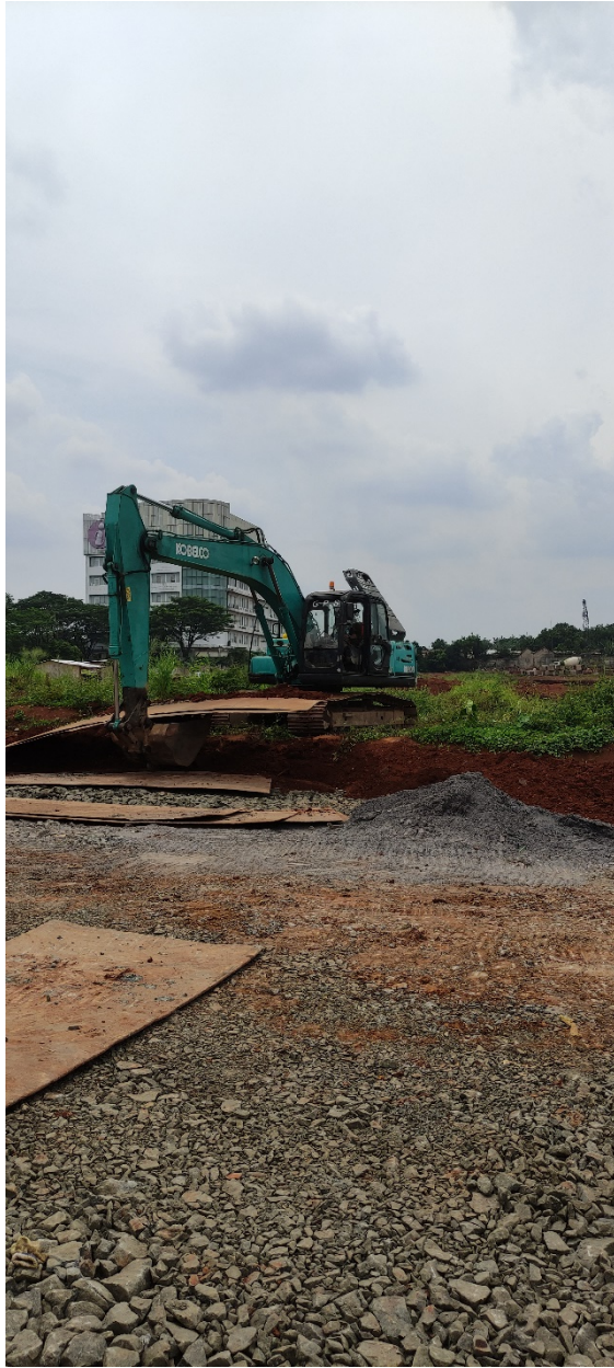
Excavator menyiapkan pelat landasan
