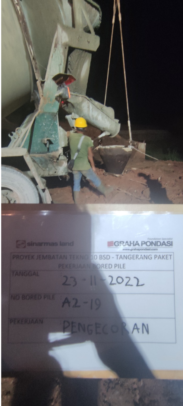
Proses pengecoran lubang
