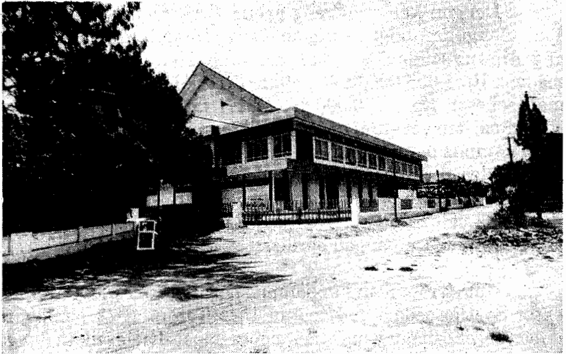
Aula UAJY Mrican Baru : awal pembangunan kampus (dtj)
