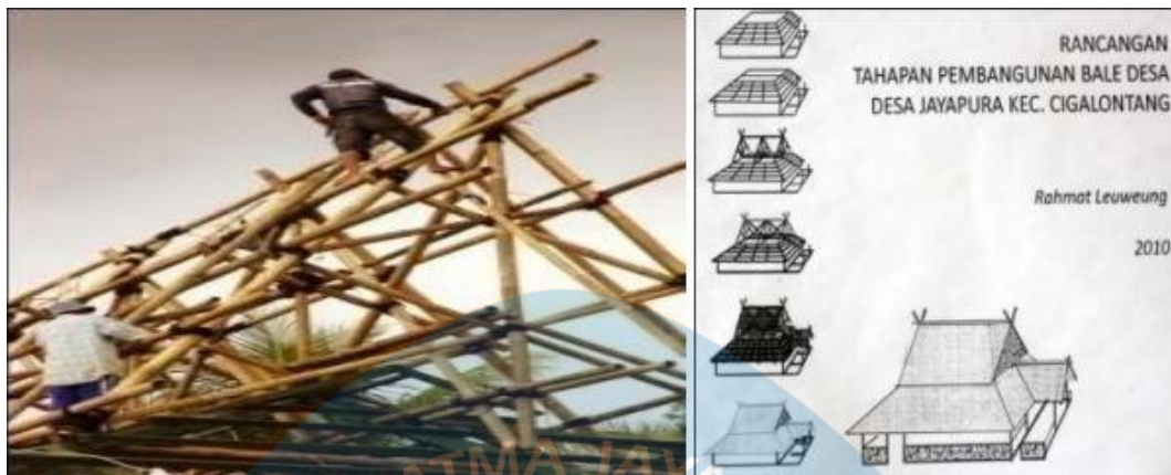
Gambar 3.9 Konstruksi Atap Bambu
