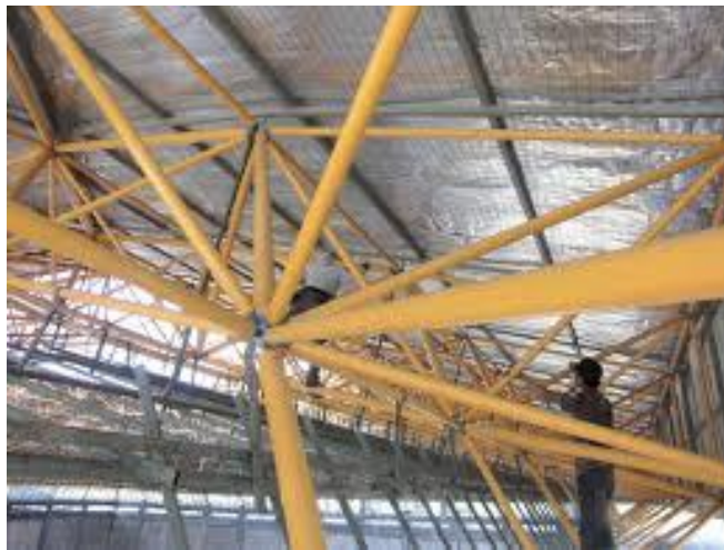
Gambar 6.32 Struktur Rangka Ruang
