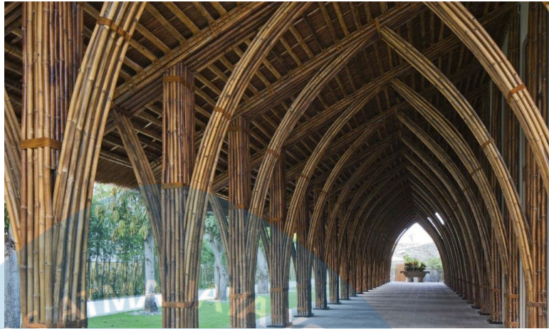
Gambar 6. 9 Struktur menggunakan material bambu
