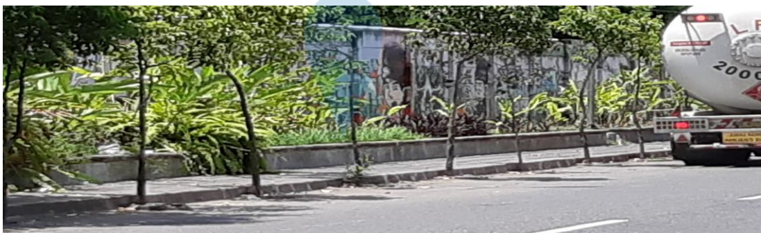
Gambar ppj 4 kondisi trotoar pada jalan Kebun Raya
