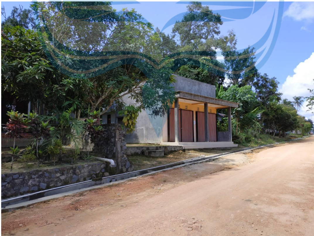
Gambar 3. 16 Drainase pada site
