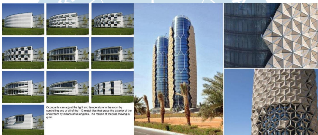
Penerapan fasad dinamis pada Kiefer Technic Showroom (kanan) dan Al Bahar Towers (Kiri)
