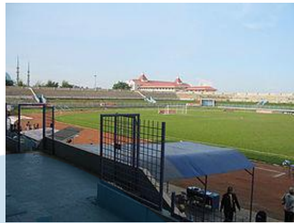
Gambar 5.1 Kondisi Stadion Benteng Sebelum Rusak
