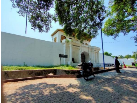
Gambar 1.8 Kondisi Benteng Vastenburg Setelah Pembenahan Sumber: Dokumentasi Penulis, 2020
