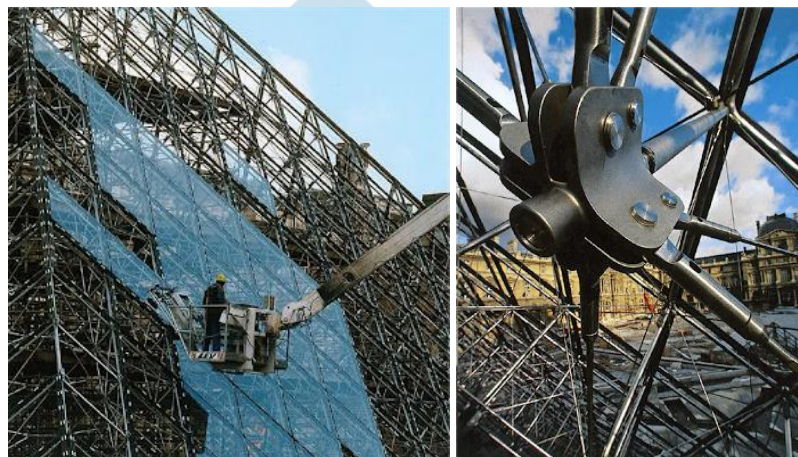
Gambar 4.33 Proses Pembangunan dan Detil Sambungan Piramida Sumber: Façades Confidential (diakses pada 25 April 2020 melalui http://facadesconfidential.blogspot.com/ )
