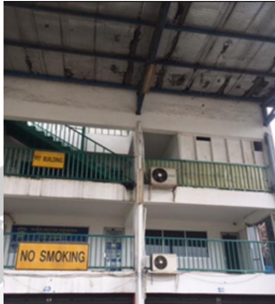
Gambar 2. 3 Gambar Kompresor AC di dalam Pit building
