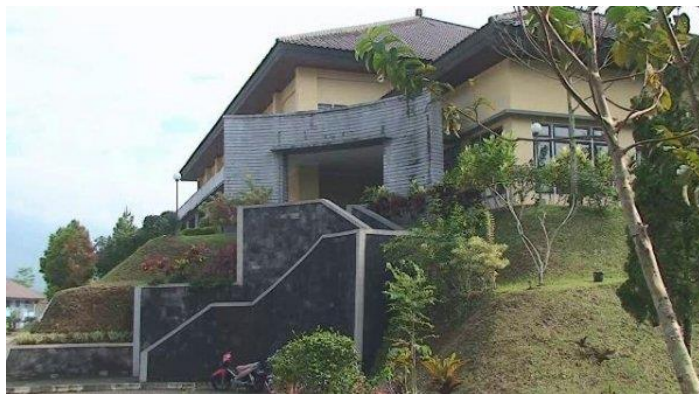
Gambar 2.2. Gedung Serbaguna Sumber: www.babesrehab-bnn.info
