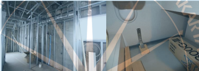
Gambar 2.14 Rangka baja ringan pada dinding beton bertulang
