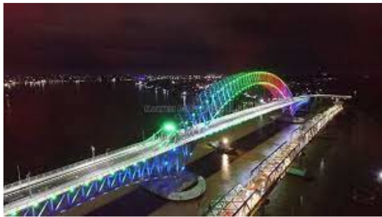
Gambar 60 Jembatan Mahakam IV
