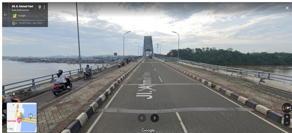
Gambar 31 Jln. Jembatan Mahakam
