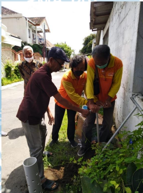
GAMBAR 2.3 Pembuatan Lubang Biopori
