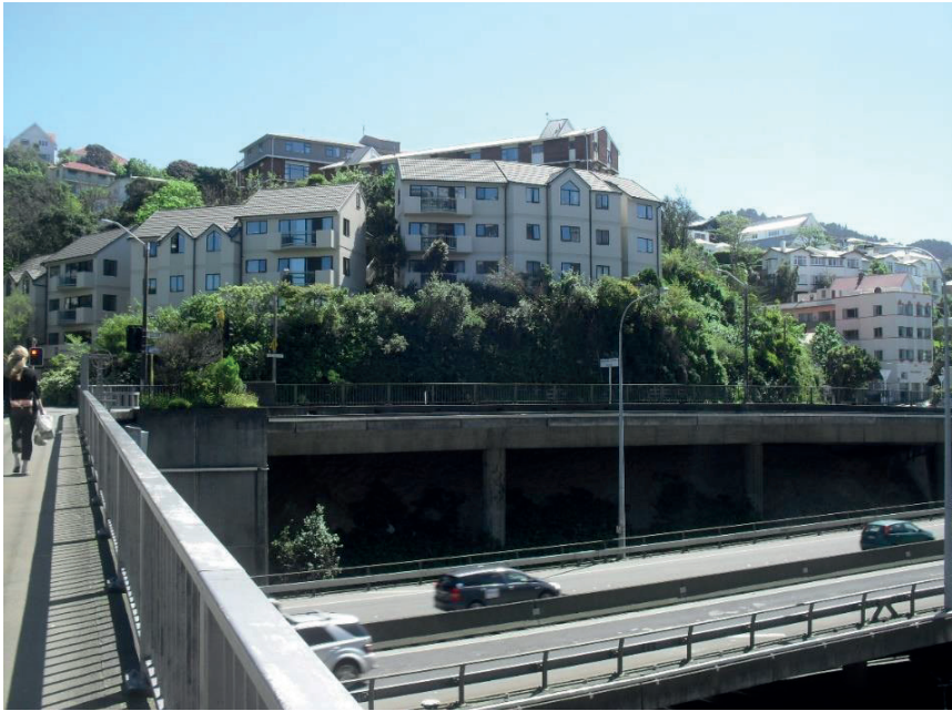
Gambar 32 Asrama mahasiswa di Wellington, Everton Hall, terletak persis di tepi jalan raya. Jendela harus selalu tertutup karena kebisingan dari jalan raya masuk ke kamar bila jendela dibuka. Diperlukan jendela kedap bunyi untuk mengurangi kebisingan dari jalan raya di bawahnya. (sumber: Satwiko)
