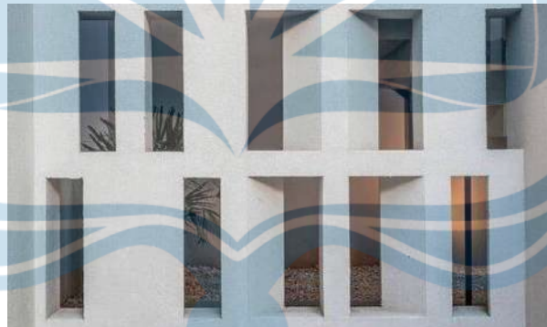
Gambar 5.9 Material GRC pada Fasad Bangunan
