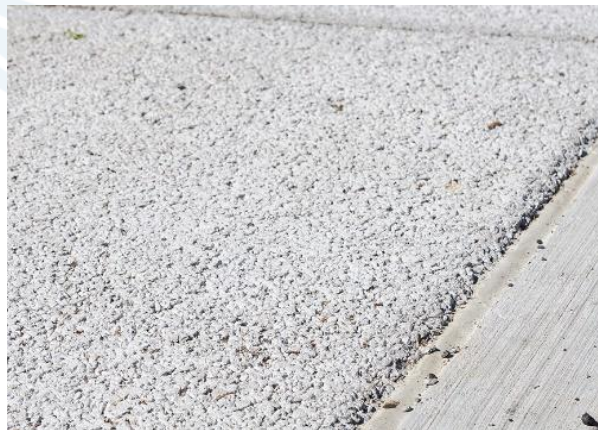
Gambar 3.7.2.2 Beton Tembus Air
