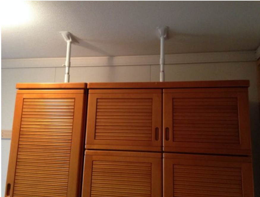
Gambar 2. 6 Mengamankan Perabot dengan Tiang Penahan Sumber: (Dekoruma, 2019)
