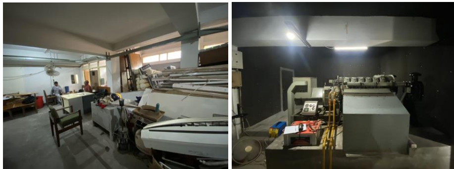
Gambar 3.20 Gudang Genset Sumber: Dokumentasi Penulis
